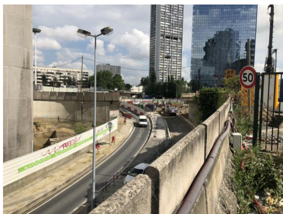
Portique démolit – une première étape a été accomplie et permet de libérer l'emprise pour construire la tour.
