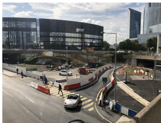
Chantier en cours
