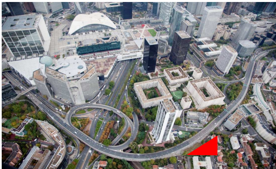
Le Boulevard circulaire Sud (au premier plan : l'échangeur de la Rose de Cherbourg et en rouge l'îlot Chantecoq)
